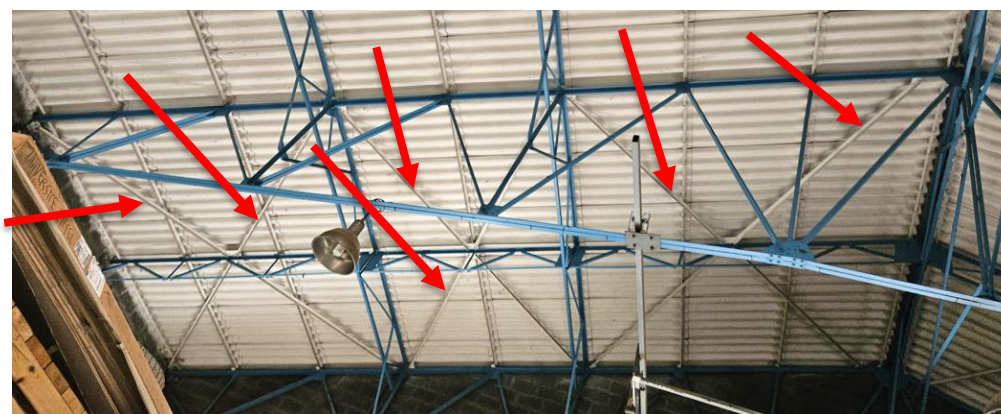
Illustration 19 : Contreventement en toiture
