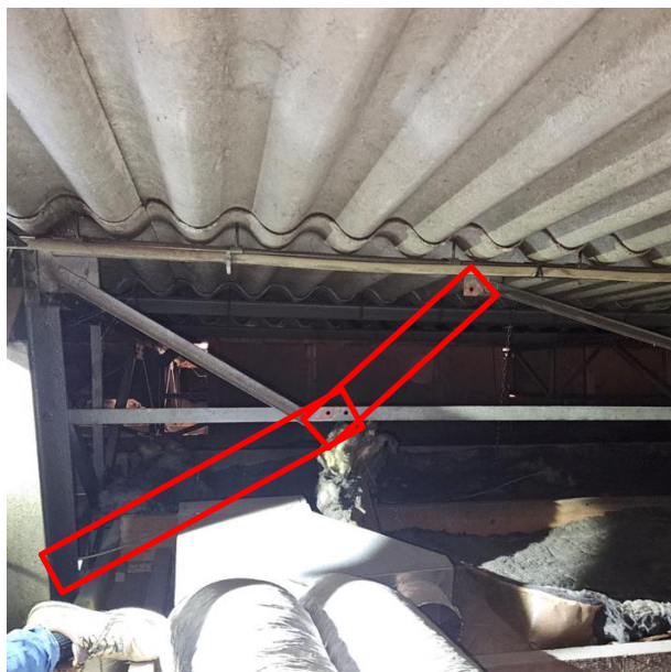
Illustration 25 : Elément manquant
