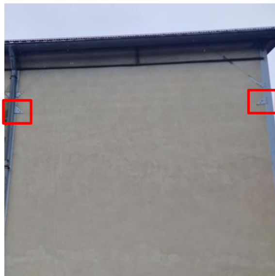
Illustration 21 : Ancienne fixation de stabilité verticale façade Nord-Est
