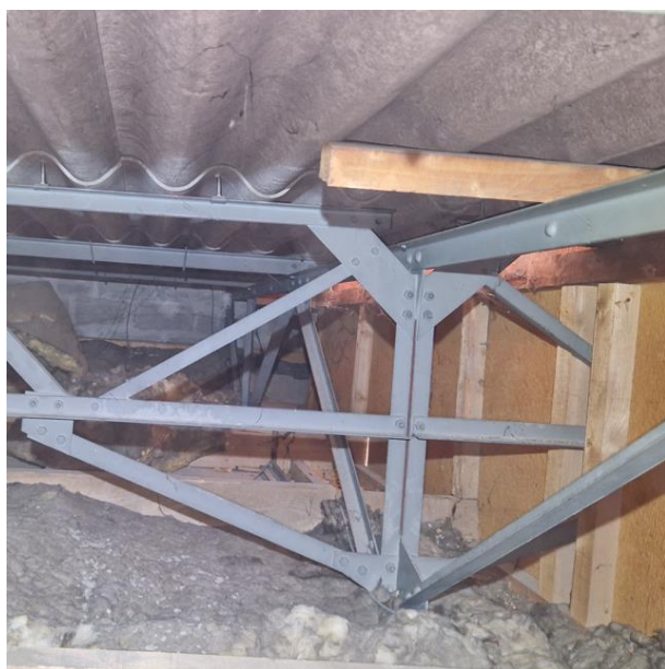
Illustration 23 : Treillis en cornières dans la partie extension
