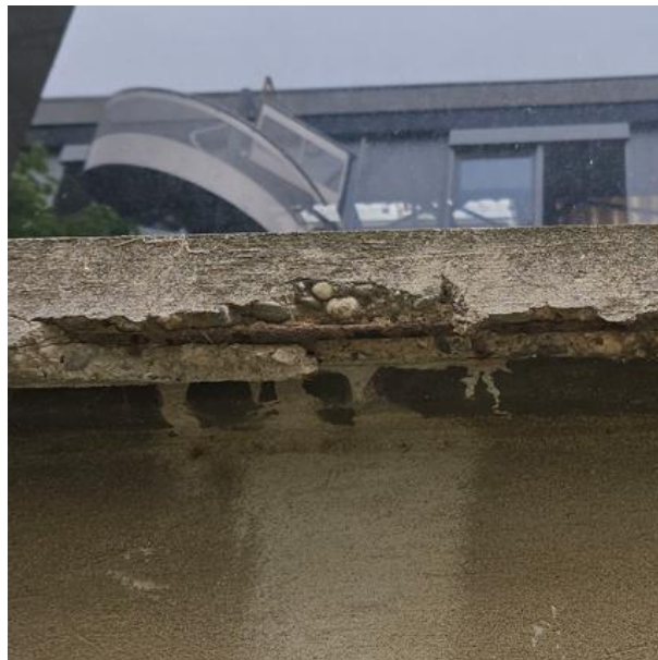
Illustration 30 : Eclats de béton et armatures oxydées
