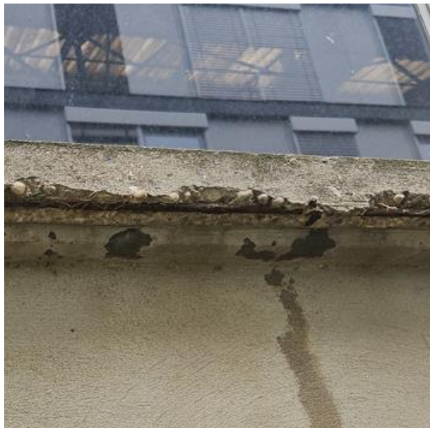
Illustration 29 : Eclats de béton et armatures oxydées
