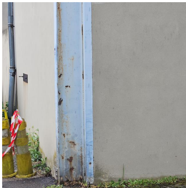
Illustration 28 : Corrosion sur poteau
