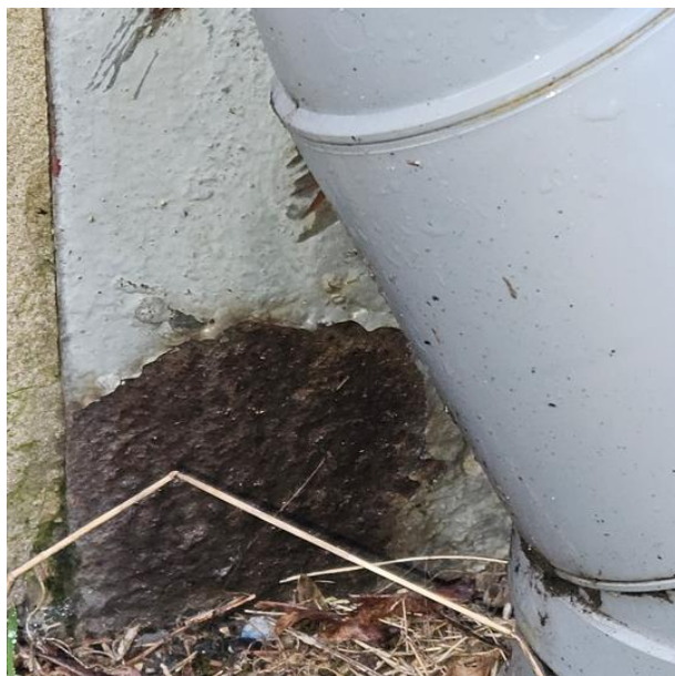
Illustration 27 : Corrosion sur pied de poteau
