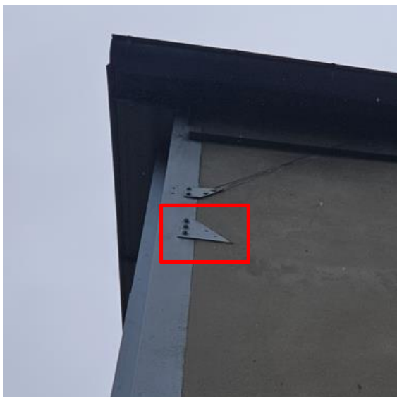
Illustration 20 : Ancienne fixation de stabilité verticale façade Sud-Est
